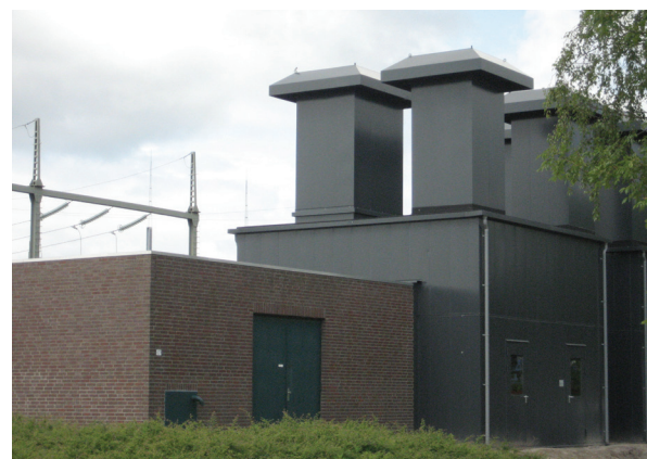
Geluidsisolerende omkasting type SKS rondom WKK-installatie
